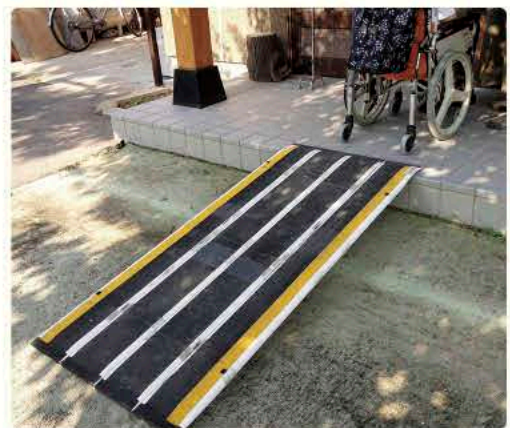
外玄関スロープ(改修前)
